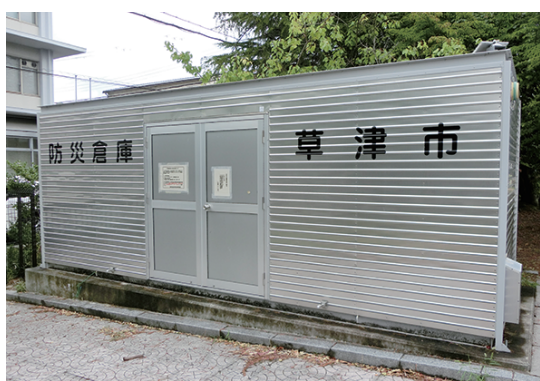
↑ 防災びちく倉庫
