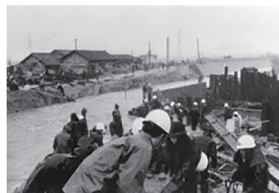
豪雨による水害 草津川国道1号付近 1966(昭和41)年
