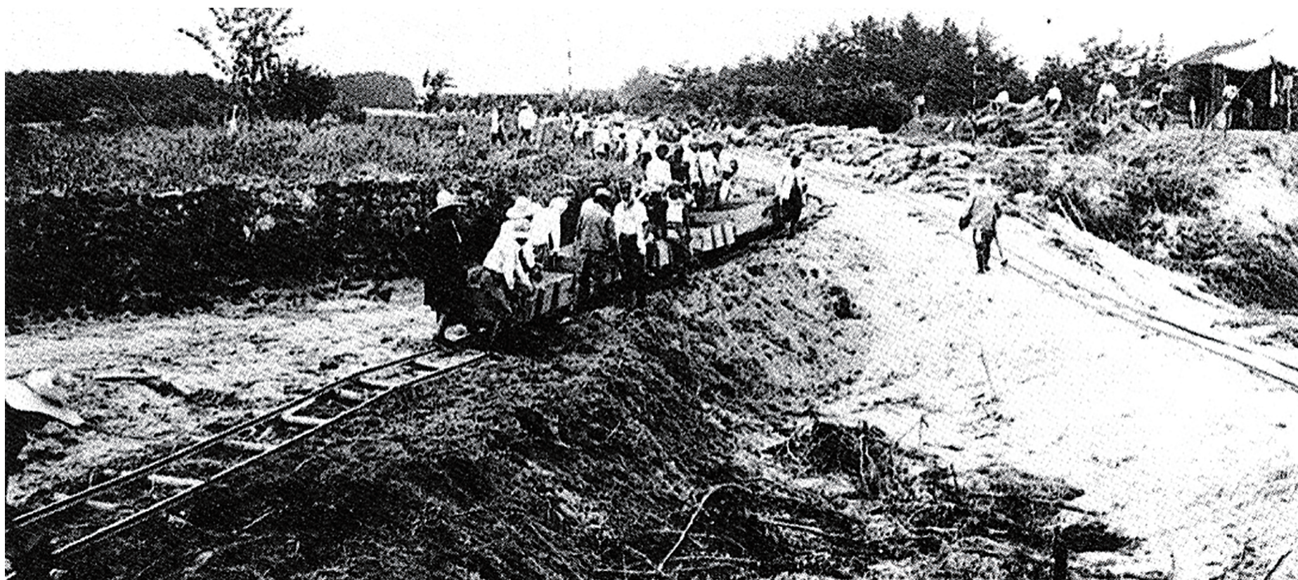
1938(昭和13)年，大雨で草津川のていぼうがきれ，馬場町で大きなひ害が出ました。 トロッコを利用して土やすなを運んで，ていぼうを直しています。
